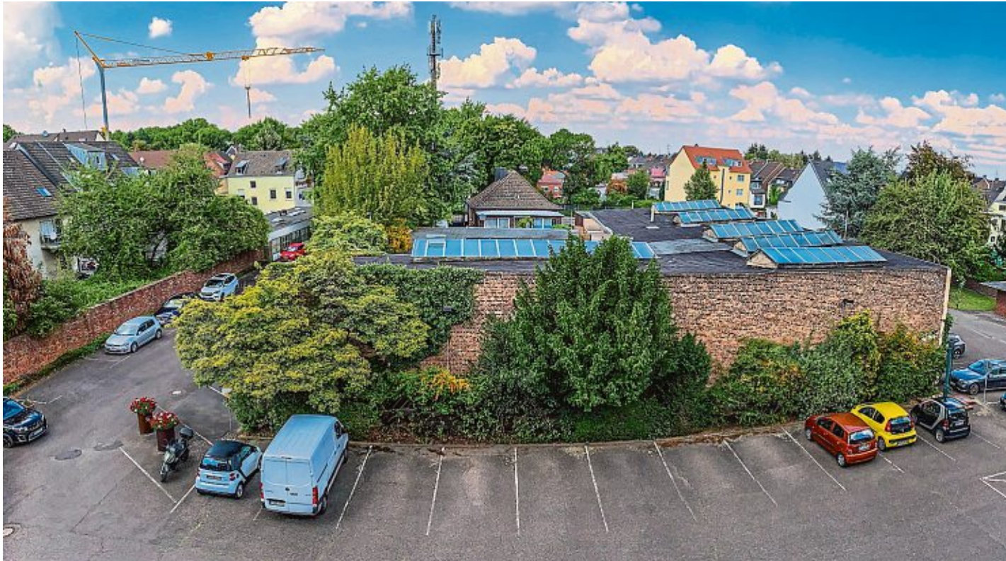
Auf dem Innenhof der Wolf'schen Wohnungsbaugesellschaft sollen sieben neuen Häuser mit rund 72 Wohnungen entstehen. Foto: Kreidler
